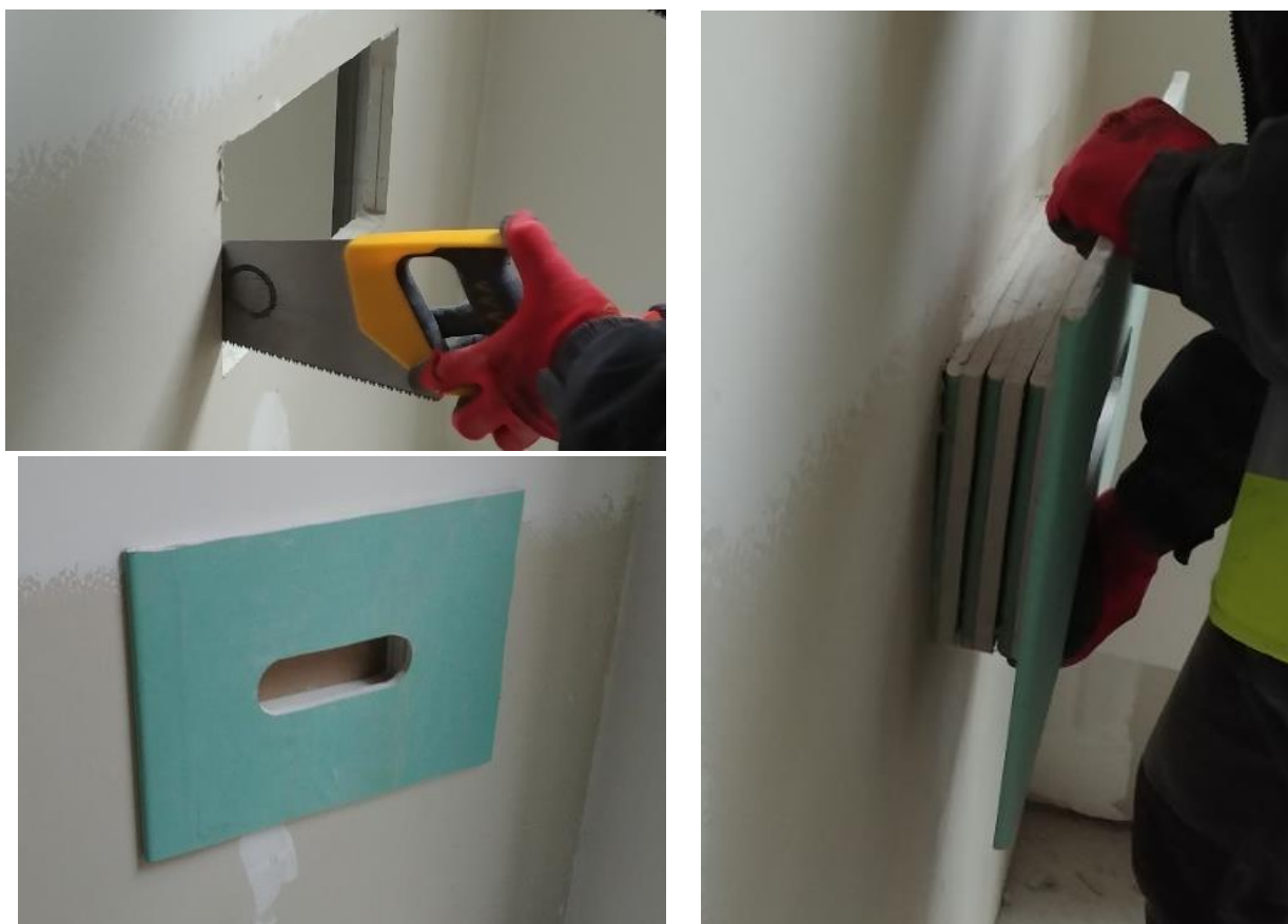
Rys. 6.2 Prawidłowy montaż elementów wyposażenia w ścianie
