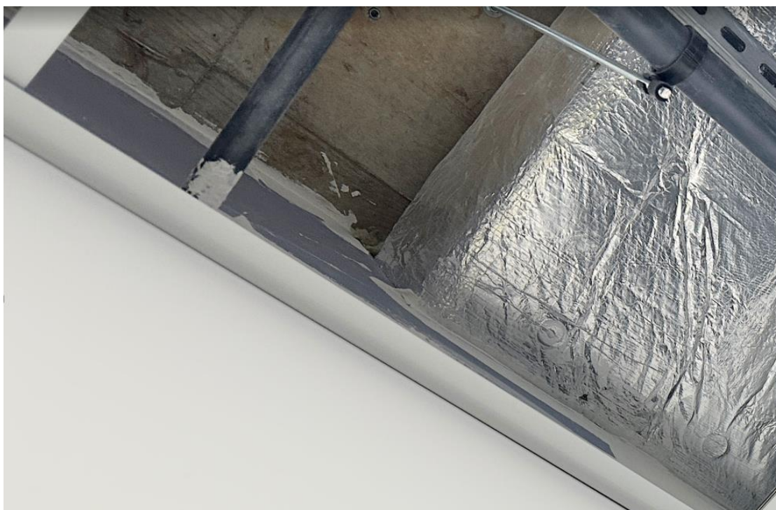
Rys. 6.3 Niepoprawnie uszczelnione przejście kanału wentylacyjnego przez ścianę
